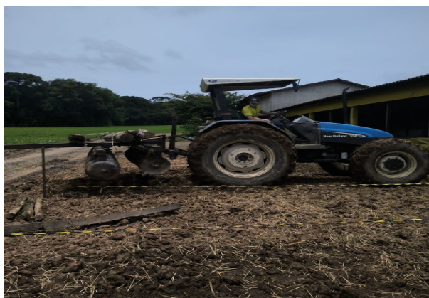
Figura 1: Compactação da área por meio da sucessiva passagem de trator
