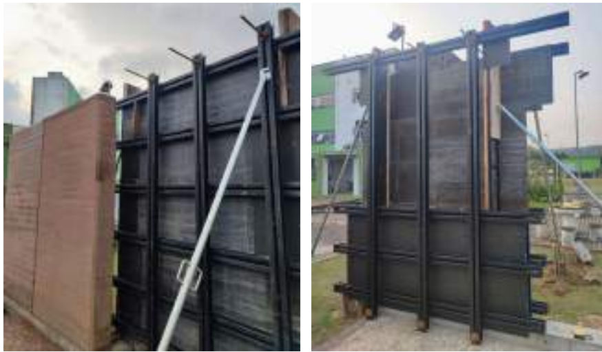
Figura 1 - Detalhamento do taipal.
