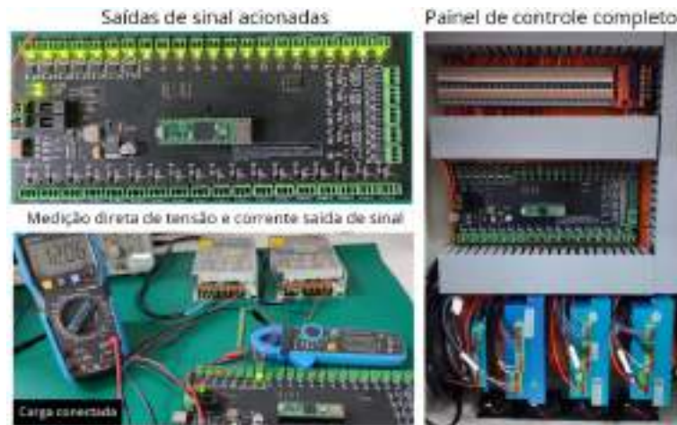
Figura 5 – Instalação do painel de controle e testes realizados com a placa.
