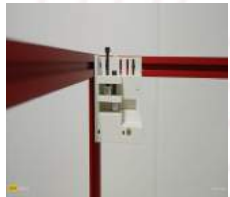
Figura 5 - Suporte fixado na estrutura
