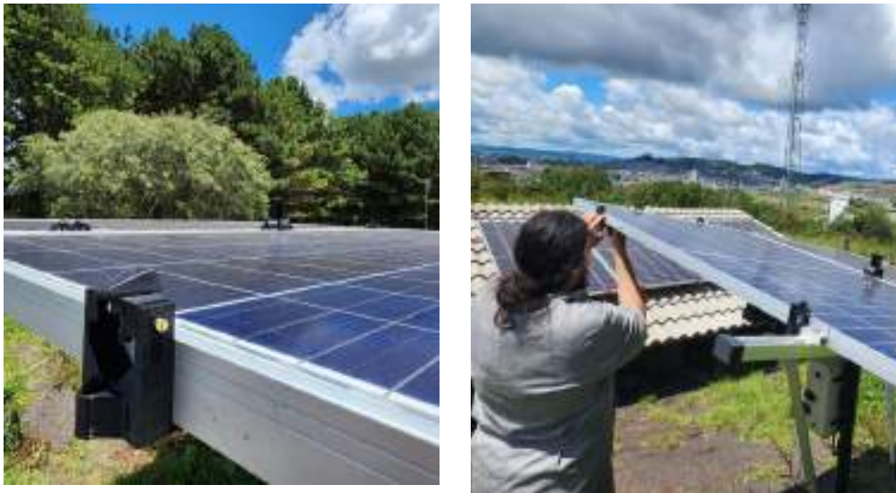
Figura 1 – Instalação do sistema de aspersão controlada de água.
