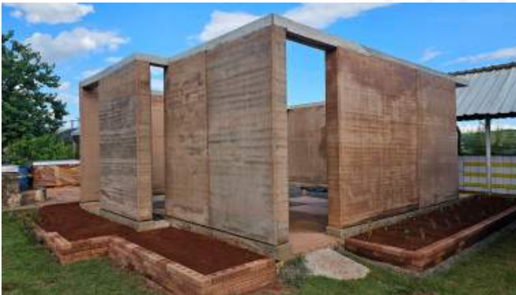
Figura 2 - Acabamento final das paredes em Taipa de Pilão e da Casa-Laboratório.
