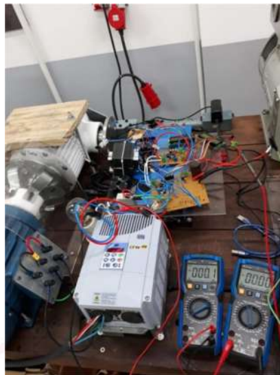
Figura 03 – Micro geração eólica de 1kW nominal implementada em bancada.
