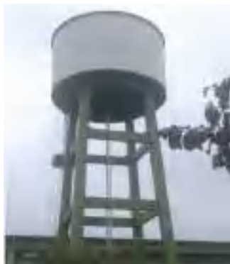
IMAGEM 1.- Reservatório Ala F Campus Florianópolis
