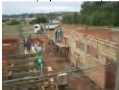
Foto 1: Construção paredes - Campus Criciúma.
