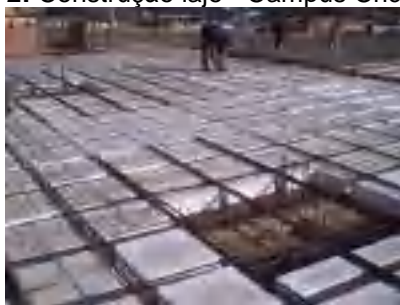
Foto 2: Construção laje - Câmpus Criciúma.
