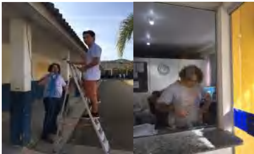
Figura 3: tarefas de instalação elétrica de fiação, instalação de sirenes e conserto de porta automática.
