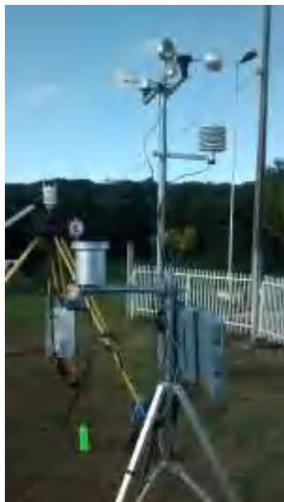
Figura 1: Instalação da EMBC01 em Chapecó. Fonte: Autor
