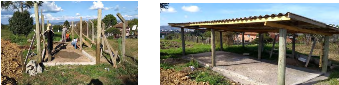
Figura 1 – Unidade de compostagem de resíduos orgânicos.
