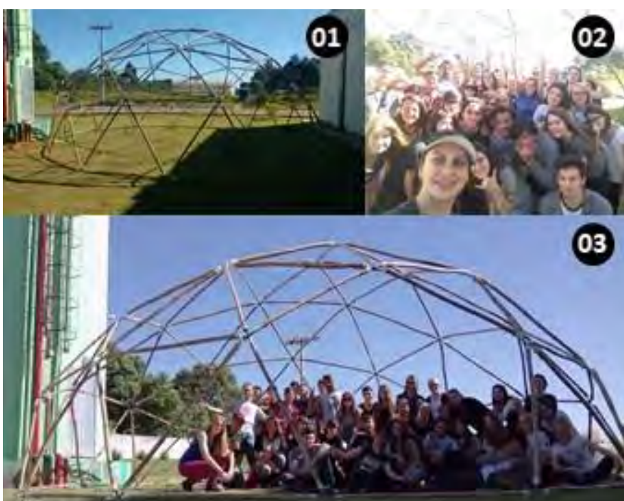
Figura 01 - Estrutura geodésica finalizada.
