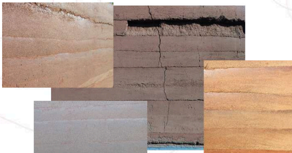
Figura 3 – Paredes experimentais executadas para fins de aprendizado prático entre os alunos.
