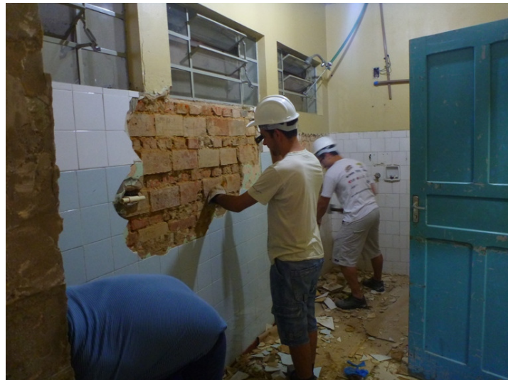
Foto 07 – BWC da área masculina após a reforma.
