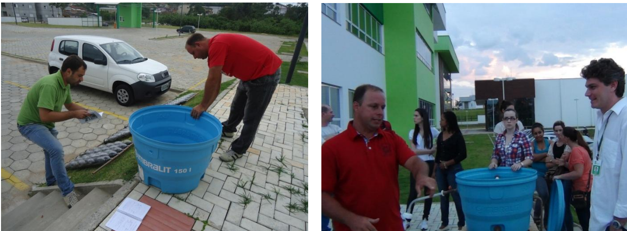
Figura 04 – Coletor anexado no reservatório e instalado no campus da instituição.
